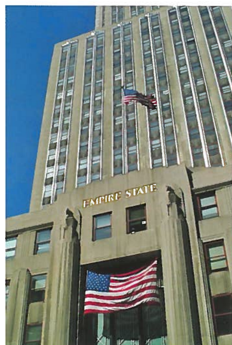
Het energieverbruik van het Empire State Building in New York is via een ESCo met 38% teruggedrongen; een besparing van 4,4 miljoen dollar op jaarbasis.
